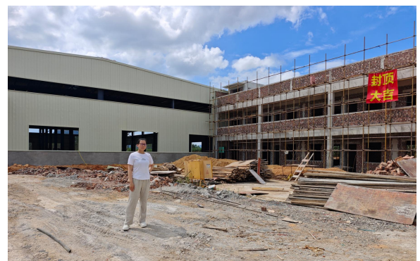
工程师现场踏勘照片2
