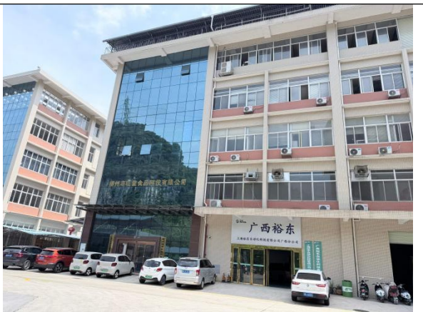
项目北侧的企业
