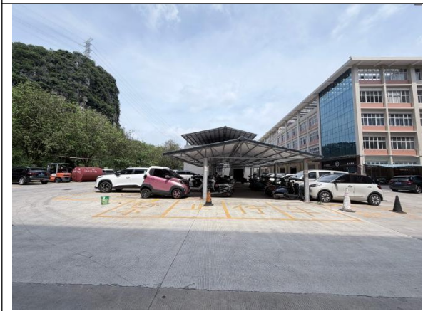
项目西侧现状
