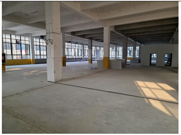
项目厂区现状
