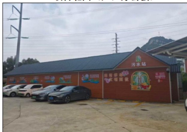
依托的污水处理站
