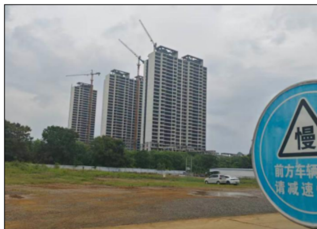
项目南面（厂区空地及停工的中房锦苑小区）
