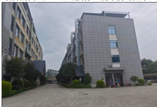
项目北面（厂区办公楼）
