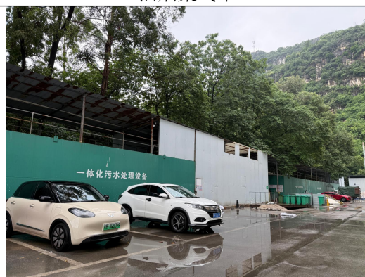
现有一体化污水处理站
