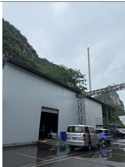
生物质锅炉排气筒
