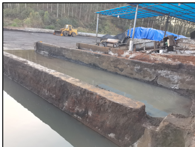
技改项目铁粉收集池和尾渣收集池
