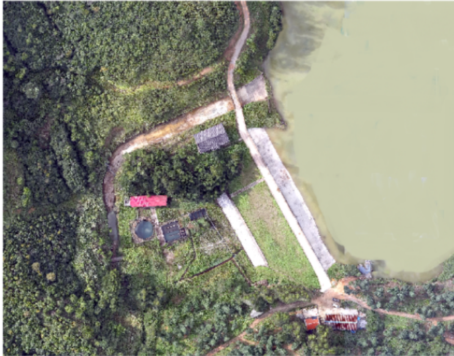
图 1 桐林水库大坝现状图
