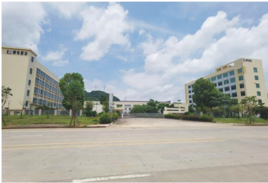
项目西面现状
