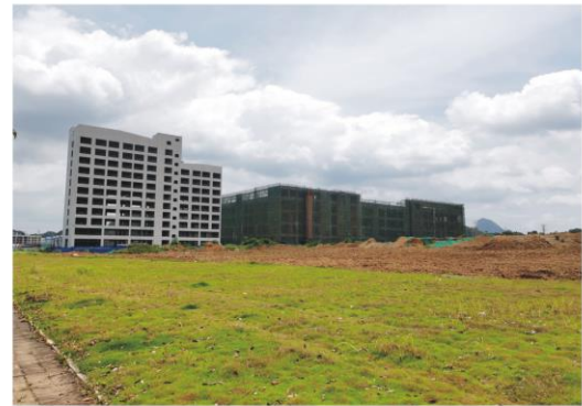
项目北面现状
